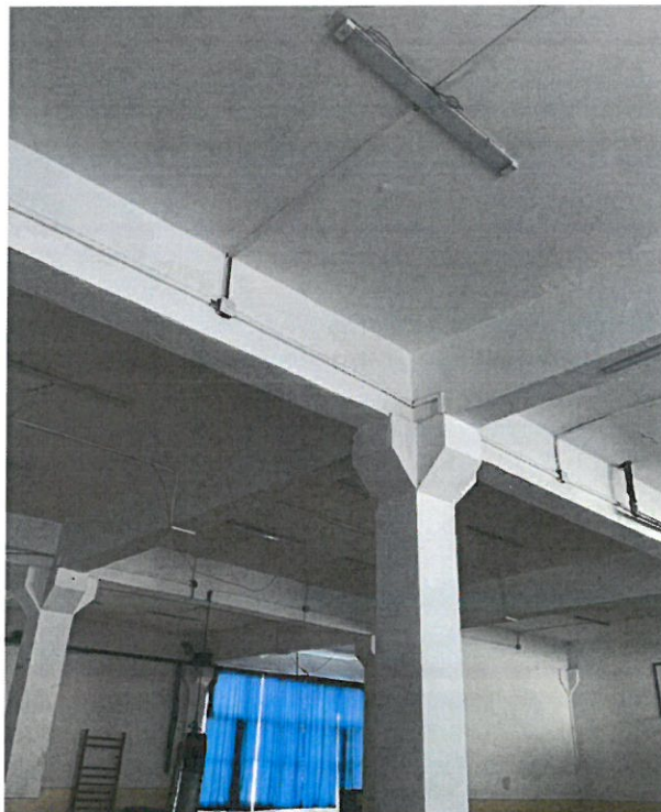
Figura 2: Planșeu peste parter cu elemente prefabricate
